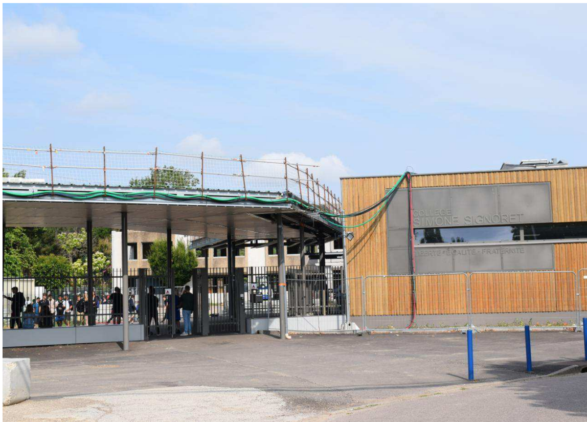
Le collège Simone-Signoret du Val d'Hazey n'ouvrira qu'en septembre 2024 suite à un retard de chantier.
