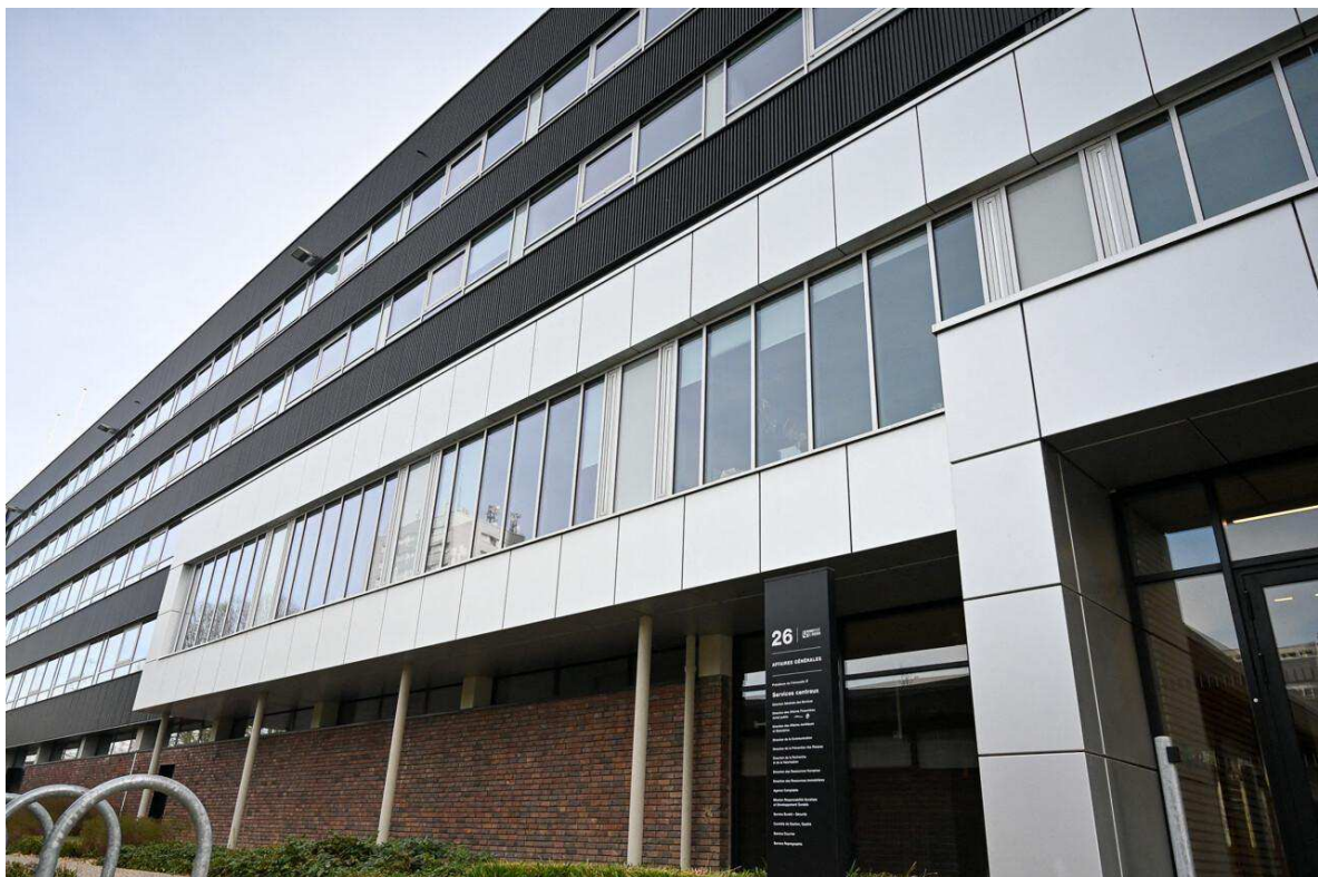
Le bâtiment de la présidence a lui été récemment rénové
