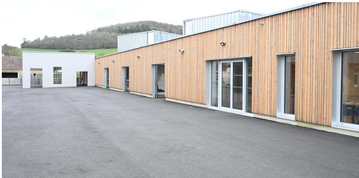
La nouvelle école maternelle de Saint-Rémy-sur-Orne dispose d'une ossature en bois. Ouest-France
