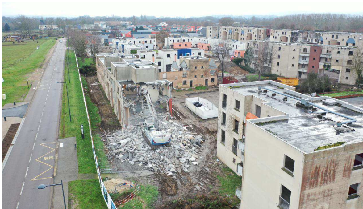
La déconstruction du quartier du Mail a démarré. Ville de Val-de-Reuil
