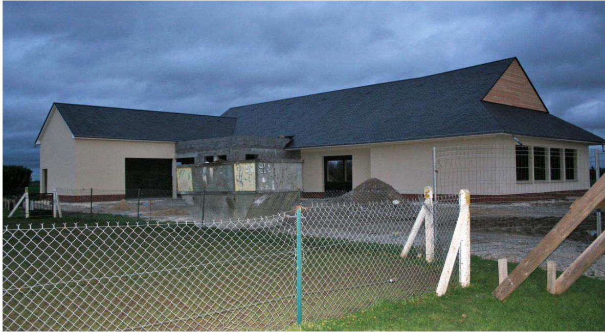
La nouvelle école primaire est en construction.
