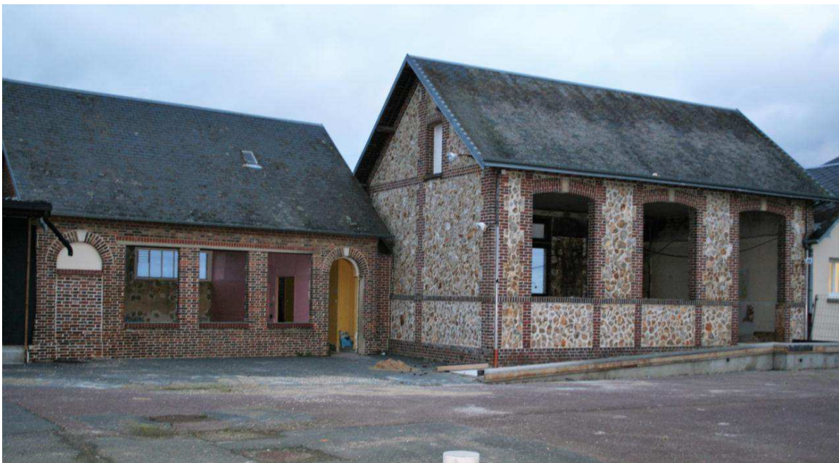
L'école maternelle est en travaux.
