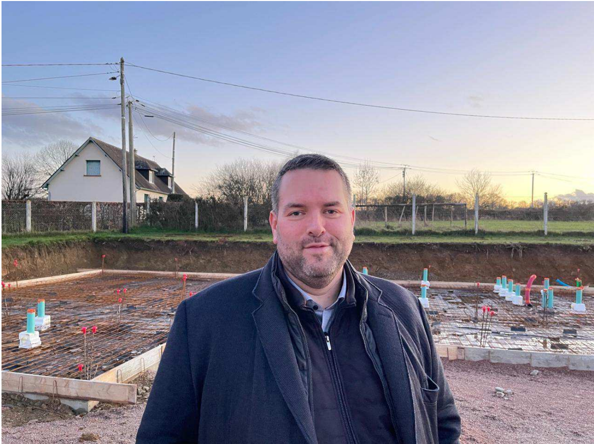
Le maire Kevin Dewaële sur le chantier de la future école maternelle. Ouest-France
