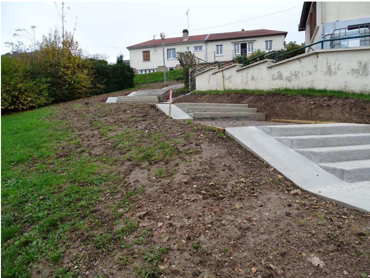
Les nouveaux escaliers coté rue de Bretagne.
