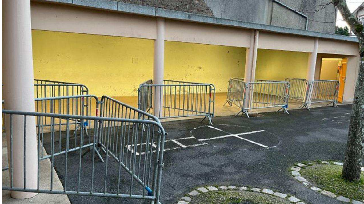
Un dispositif de sécurisation a été placé autour des poteaux du préau comportant de l'amiante. Ouest-France
