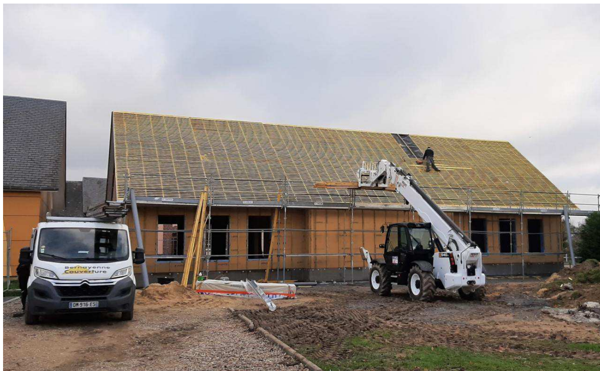
L'extension de l'école élémentaire est en cours. Mathilde Carnet
