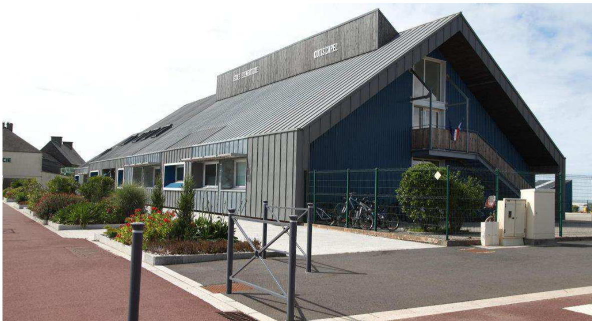
Les travaux de rénovation de l'école primaire Côtis-Capel ont duré plus de deux ans.
