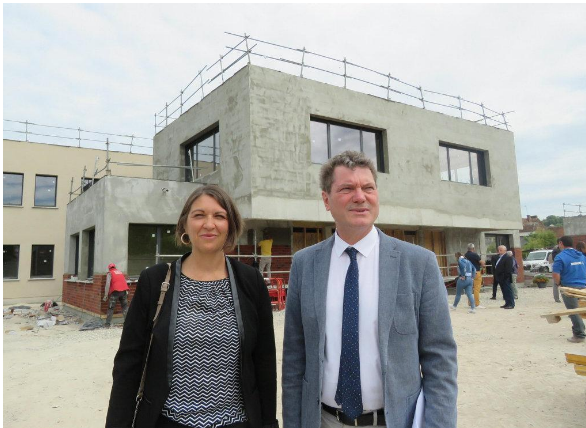
Gilles Pelletier, chef d'établissement de l'institut Saint-Joseph et Céline Hauchecorne, directrice du site de Neufchâtel-en-Bray, devant le futur établissement dont les travaux sont bien avancés.
