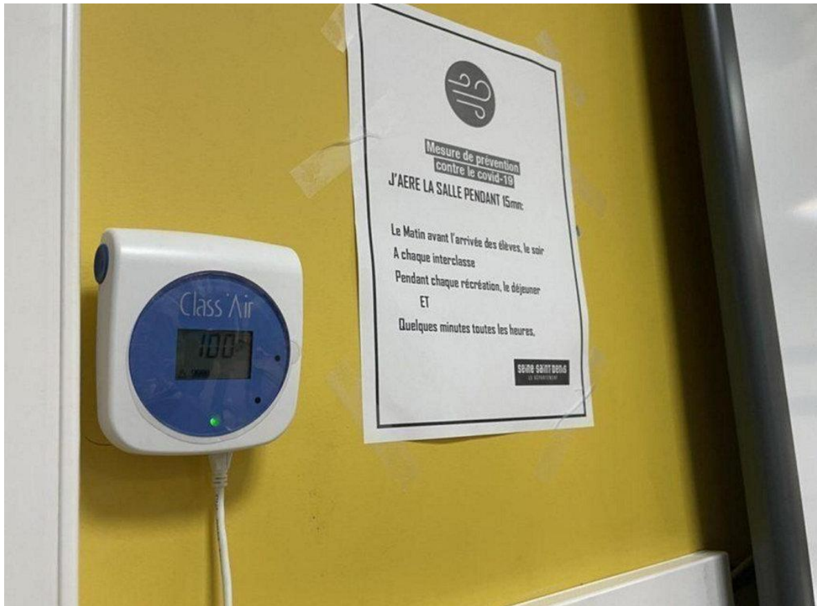
Un capteur de CO2 installé dans un collège de Seine-Saint-Denis. (©Illustration/DG/Actu Seine-Saint-Denis)
