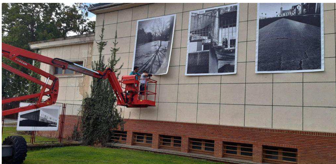
Lors de l'installation de photos sur un mur de la salle des fêtes.
