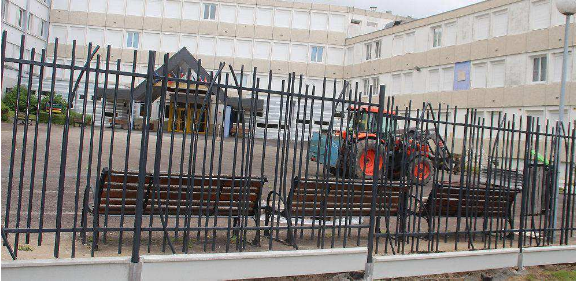
Des travaux de modification de clôture du lycée, avec remplacement des grilles et des portails.
