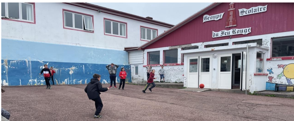
L'école élémentaire publique du Feu Rouge à Saint-Pierre, école construite il y a environ trente ans et qui devrait être provisoire. Ouest-France
