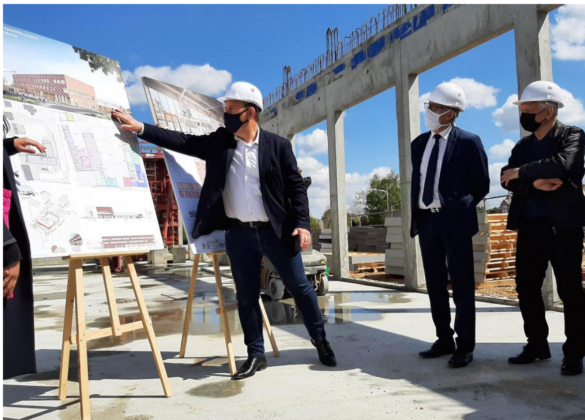
Richard Jacquet, maire de Pont-de-l'Arche, Pascal Lehongre, président du Département et Gaëtan Levitre, conseiller départemental, ont suivi la visite du chantier. (©La Dépêche de Louviers - BCP)
