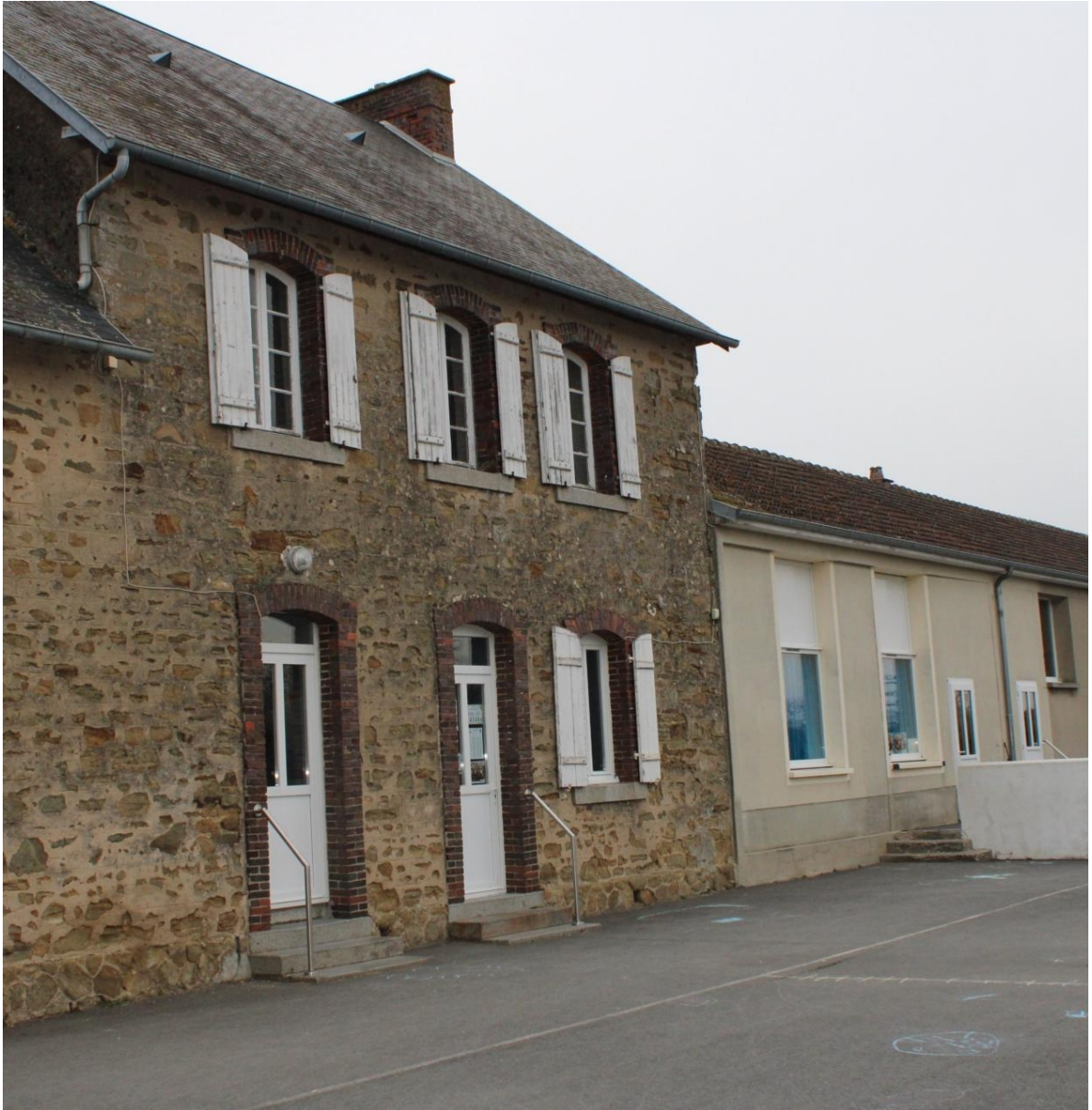
Les bâtiments de l'école de Giéville seront vides à la prochaine rentrée scolaire. Leur avenir n'a pas été évoqué mardi soir. Ouest-France
