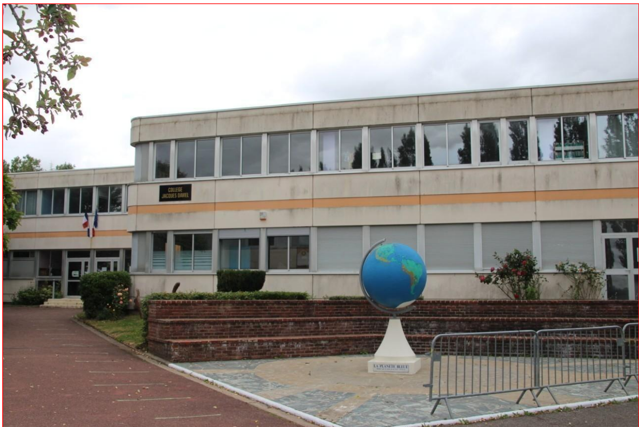
L'ancien collège Jacques Daviel sera lui démolir.
