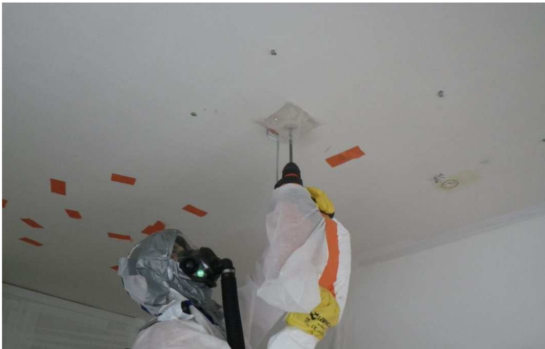
Chantier de réduction du risque amiante Aorif
