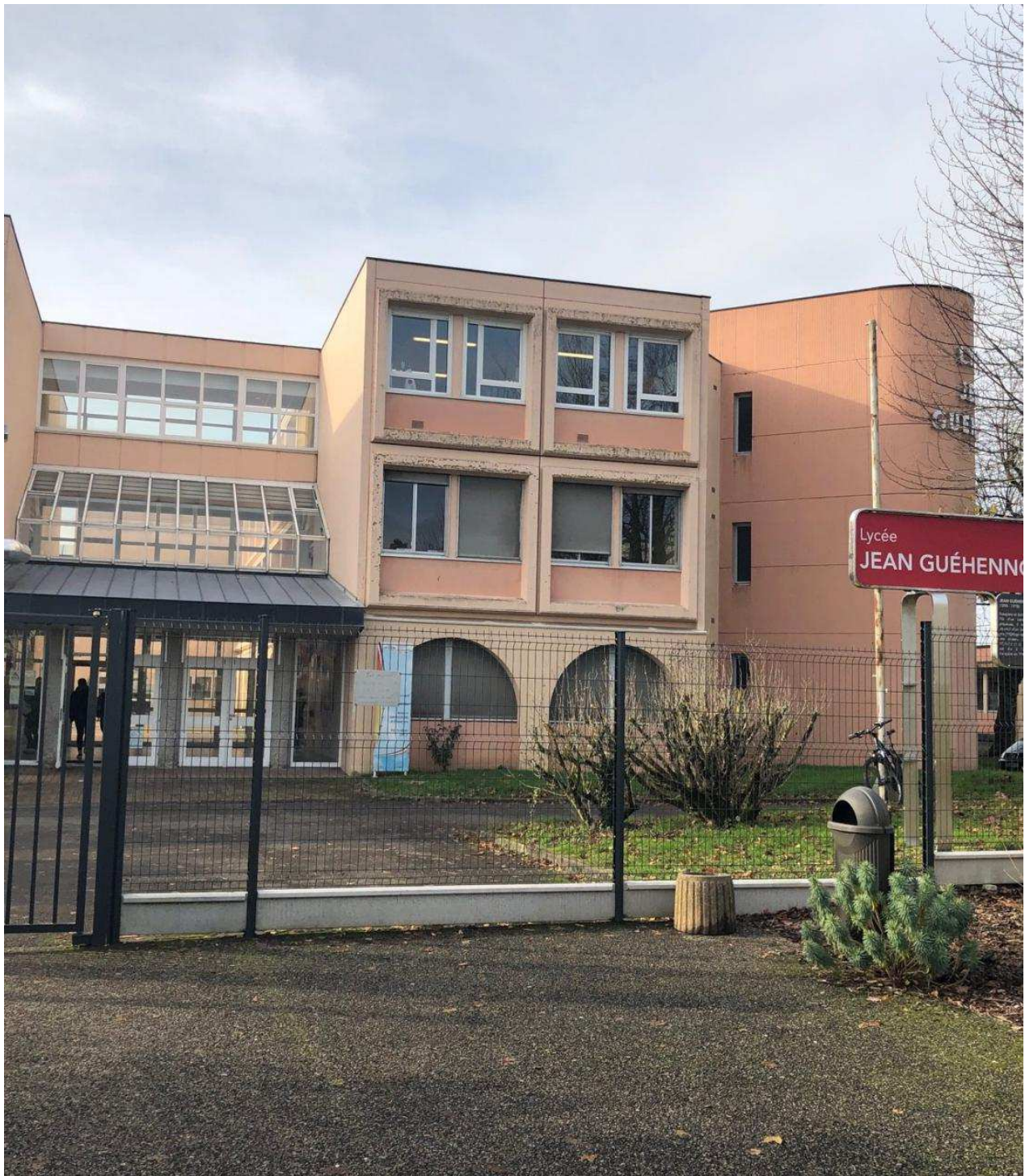
Les deux salles concernées ont été fermées en l'attente de travaux et de nouvelles mesures, au lycée Jean-Guéhenno de Flers. - Crédit: Ouest-france
