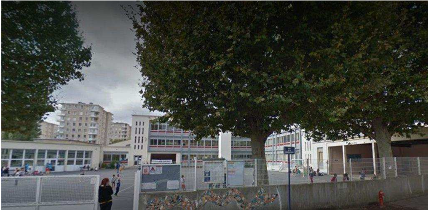
Pendant plusieurs jours, certaines classes de l'école Henri-Brunet n'étaient pas chauffées. - Crédit: Google Street View
