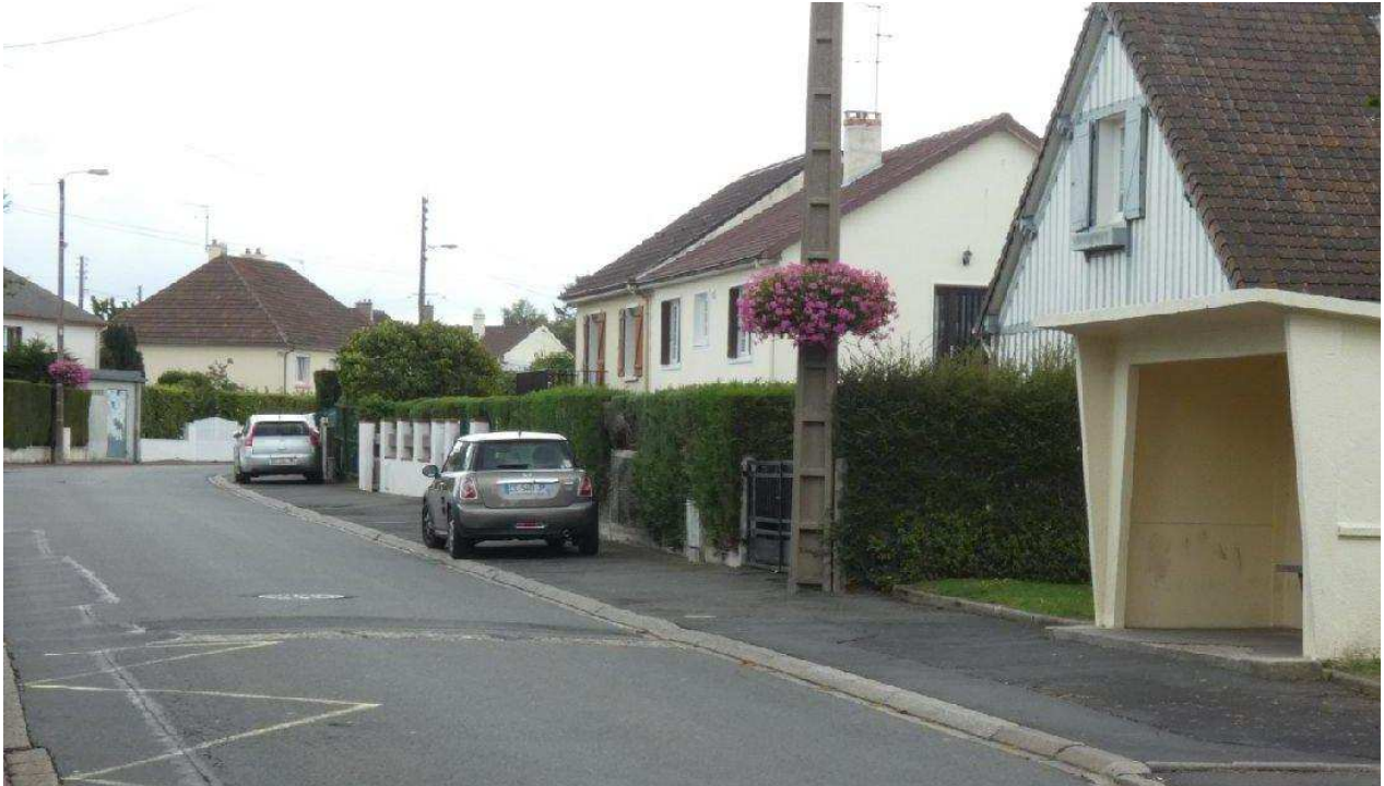
L'arrêt aux Aubets, dans la zone pavillonnaire près de l'épicerie, a été supprimé. - Crédit: Ouest-France
