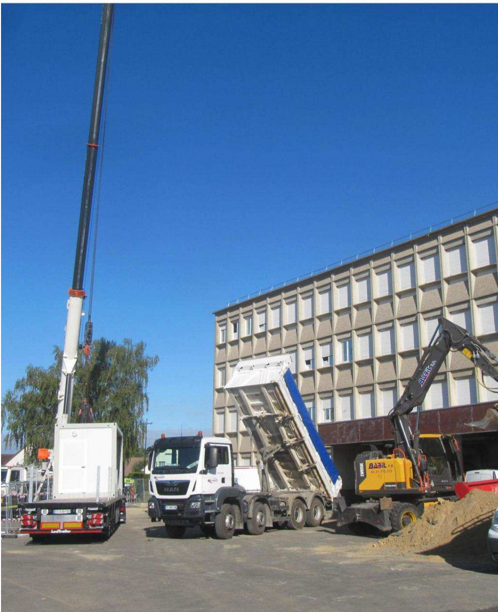
Les travaux au collège vont durer encore plus d'un an. - Crédit: Ouest-France
