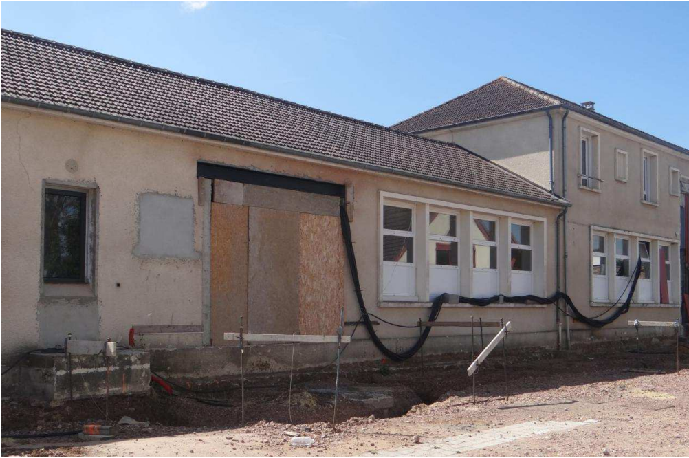
À l'arrière du bâtiment, l'espace de circulation sera encore en chantier durant quelques semaines. - Crédit: Ouest-France
