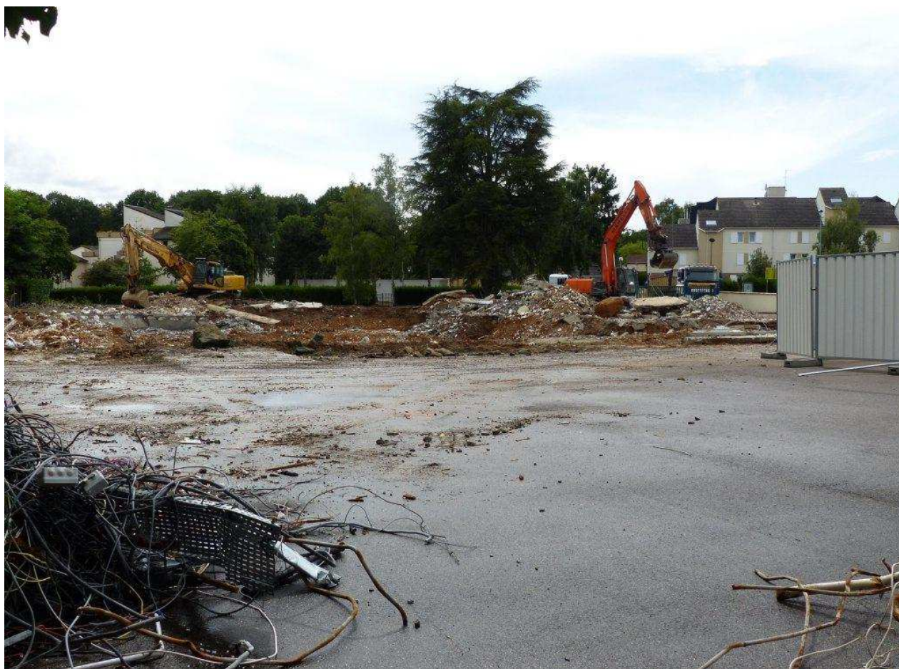
Le bâtiment à usage administratif, salles des professeurs et logements est maintenant totalement rasé.
