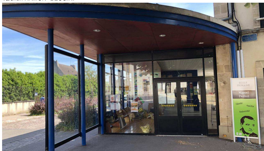
À la rentrée 2020, après les travaux, l'école Marcel-Pagnol comptera 260 élèves. - Crédit: Ouest-France
