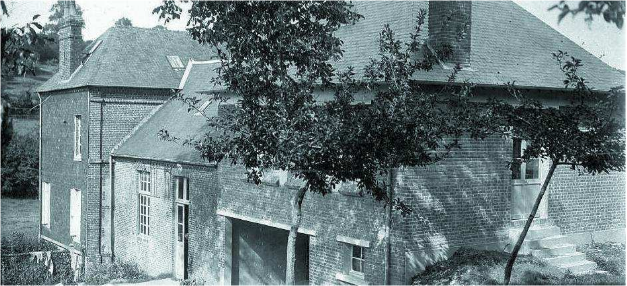
L'école de Manerbe a été dotée d'une cantine en 1949. - Crédit: DR
