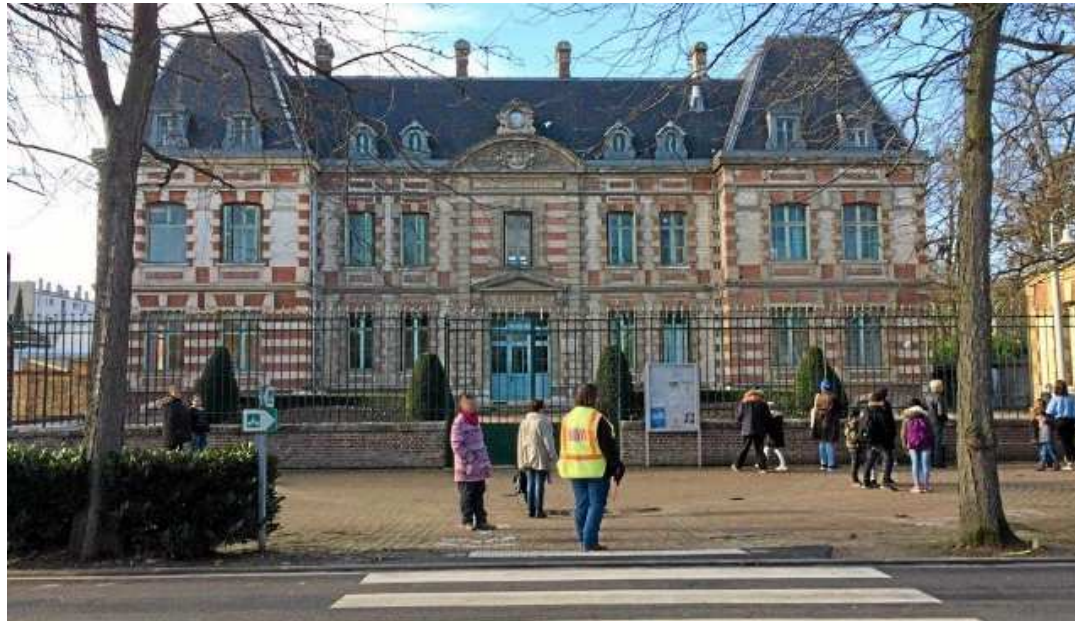
Le groupe scolaire Jules-Ferry est vétuste, si bien que tout l'étage est condamné, raison qui pousse les élus à le reconstruire. @La Dépêche de Louviers / PC
