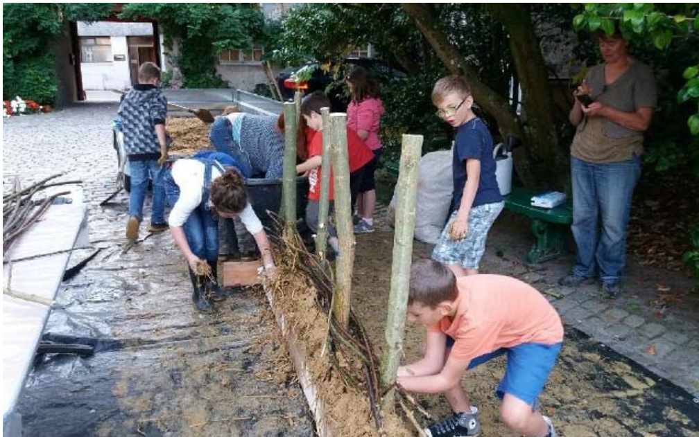
Les primaires de Roncey en plein chantier de construction. - Crédit: Ouest-France
