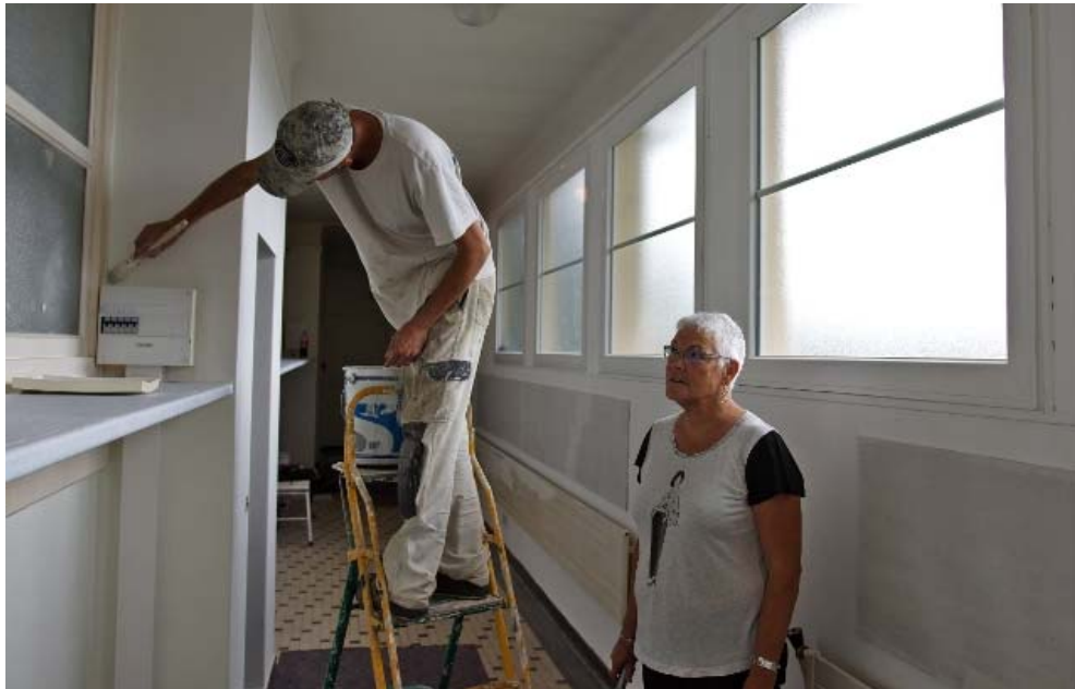
Martine Patourel, la maire, à côté d'un des peintres, dans le couloir en cours de réfection. - Crédit Ouest-France
