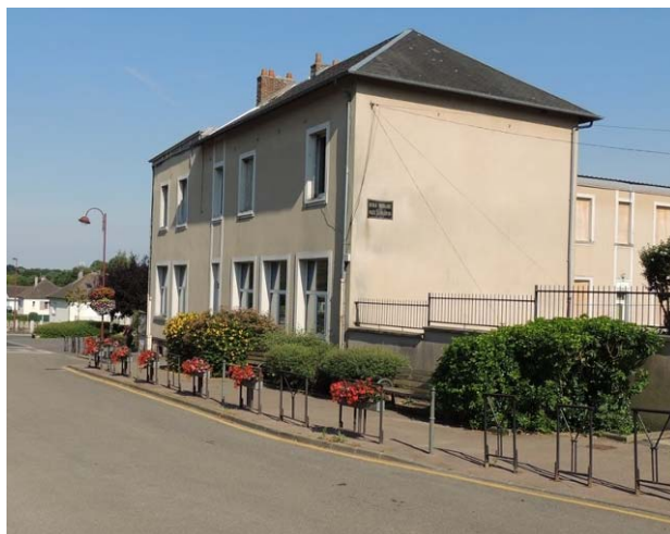
Dans le projet de reconstruction de l'école, seule la partie de l'ancien bâtiment longeant la rue Jean Moulin sera conservée. - Crédit Ouest-France
