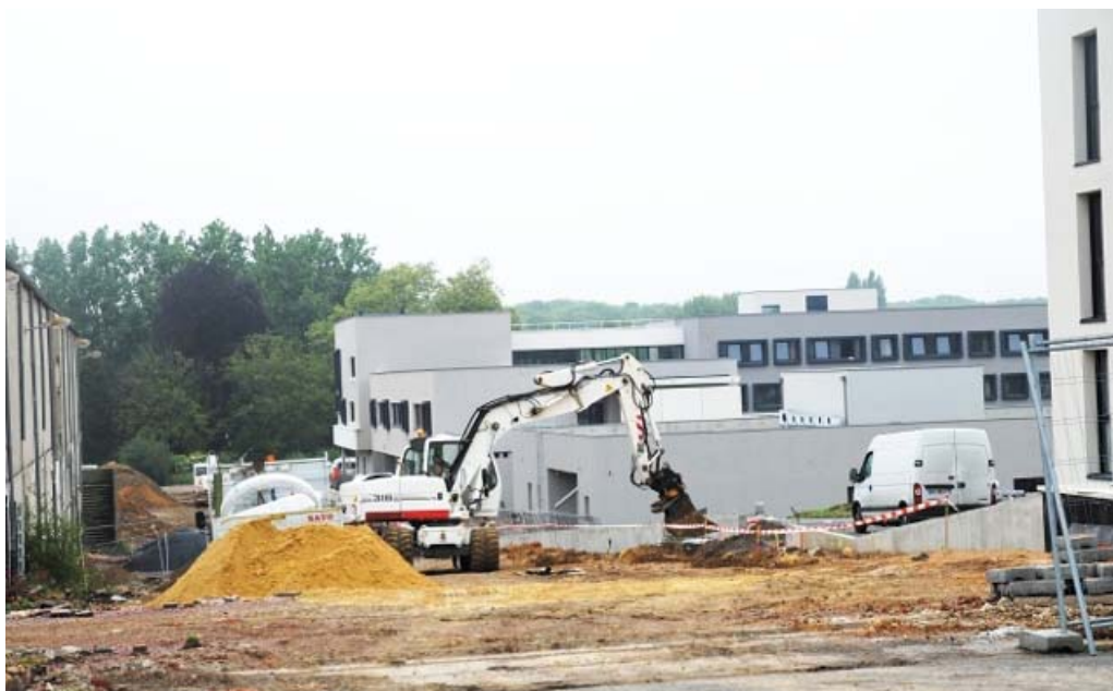
Les travaux de réalisation de la nouvelle rue Gisèle-Guillemot sont en cours. - Crédit Ouest-France
