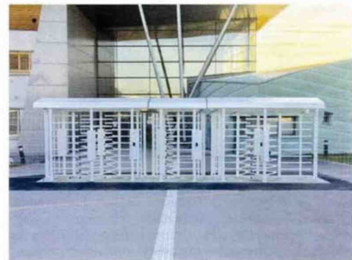
En régions PACA et Auvergne Rhône-Alpes, la société La Barrière Automatique a déployé des tourniquets "connectés" qui filtrent l'entrée de quelque 300 établissements.
