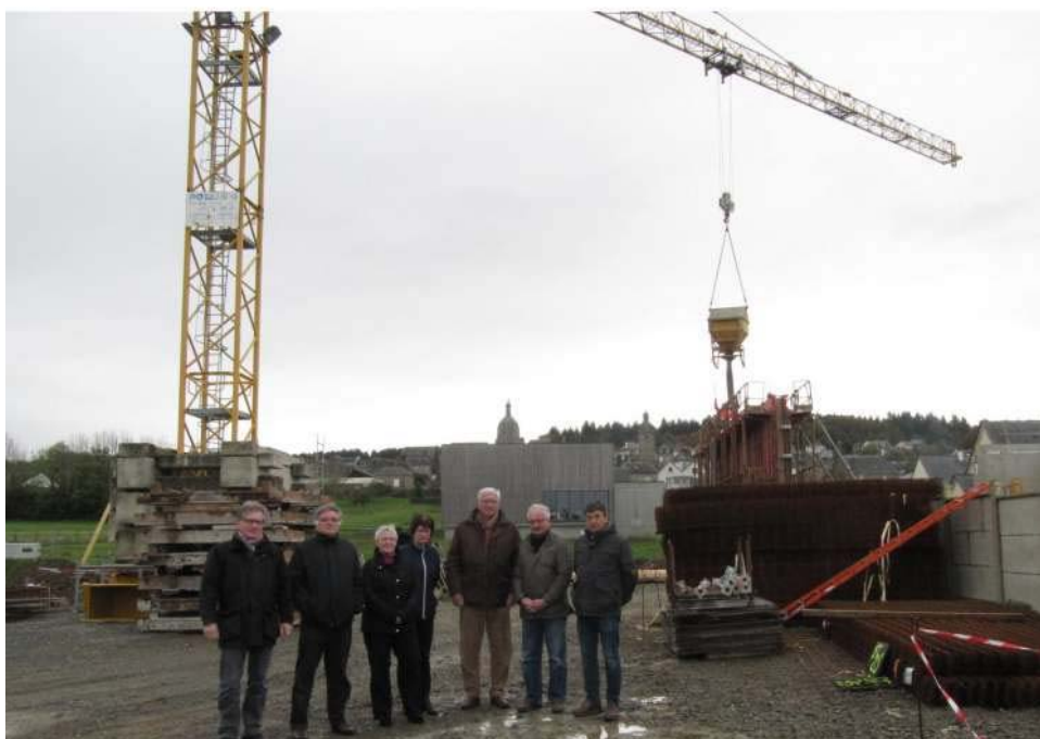
Les élus se sont rendus sur place, boulevard du Nord, pour le début des travaux. - Crédit Ouest-France
