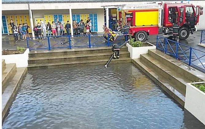
Opération de pompage dans le patio, avec les pompiers.
