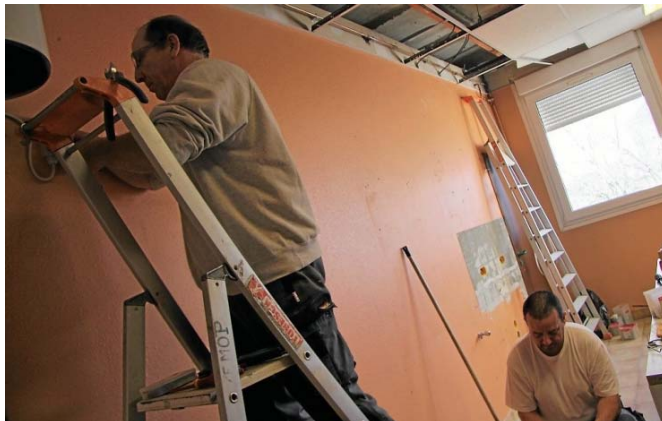
Des travaux sont en cours au lycée Louis-Liard, qui redessine notamment sa vie scolaire pour la rentrée 2017.
